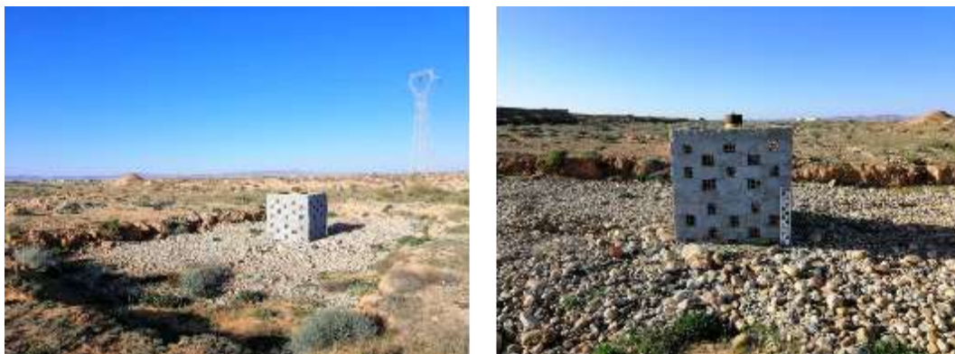
Photographie 14 : Puits filtrant installé dans l'oued.
