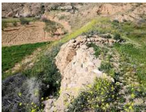
Photographie 11 : Déversoir central « Masraf ».
