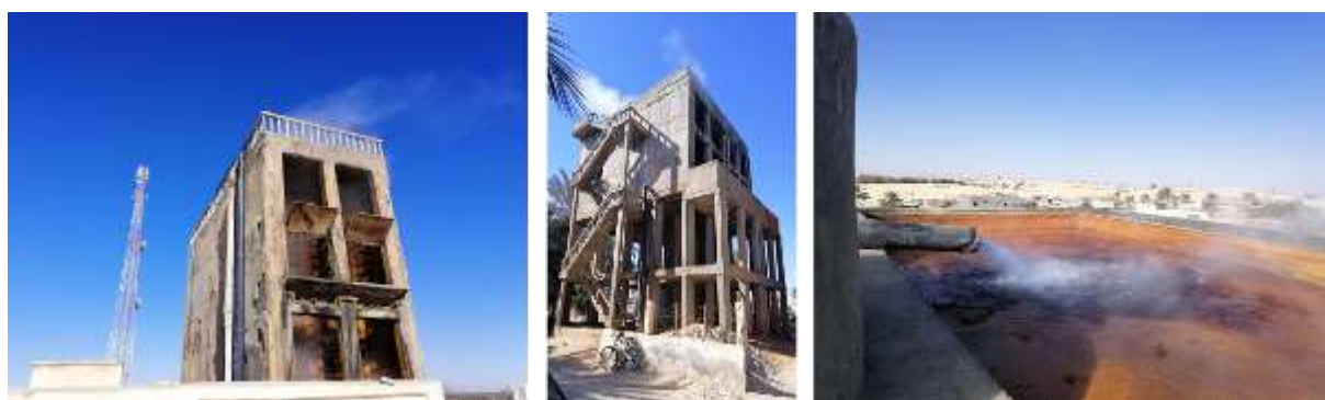
Photographie 20 : Station de captage des eaux géothermales de la nappe du CI.
