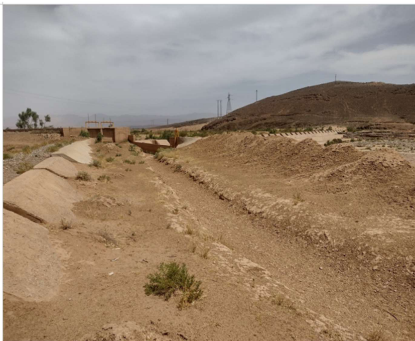
Fig. n°40 : Barrage et seguia de Ghallil au pied de Taourirt Ghallil Réalisation : T. Kuper, mai 2022
