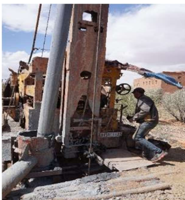
Fig. n°18 : Construction d'un forage dans la vallée de Todgha
