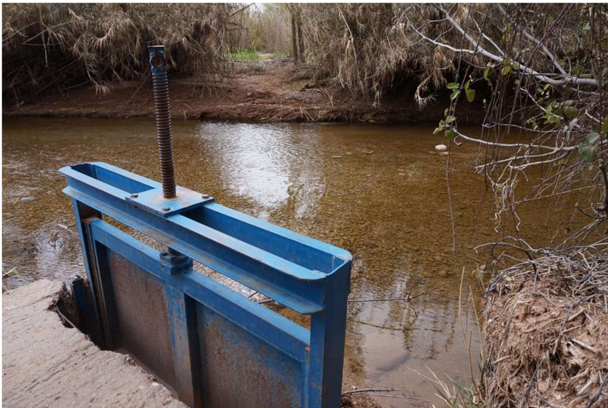
Fig. n°36: Alimentation d'une séguia en béton à Aït Aritane
