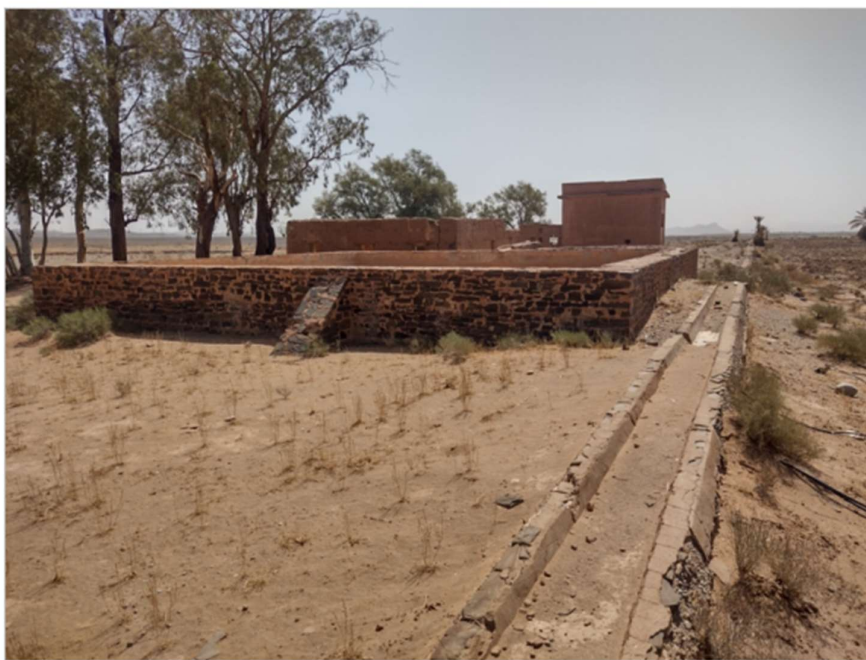
Fig. n°39 : Installations de la ferme coloniale : bassin et séguia principale Réalisation : T. Kuper, mai 2022
