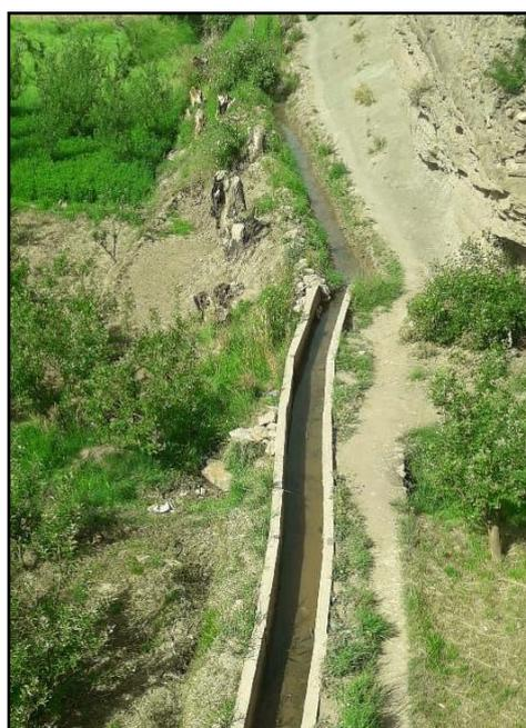
Figure 34 : Photo d'une séguia à moitié en béton
