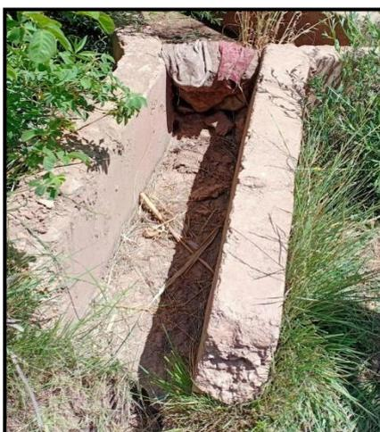
Figure 35:Photo d'une séguia détruite
