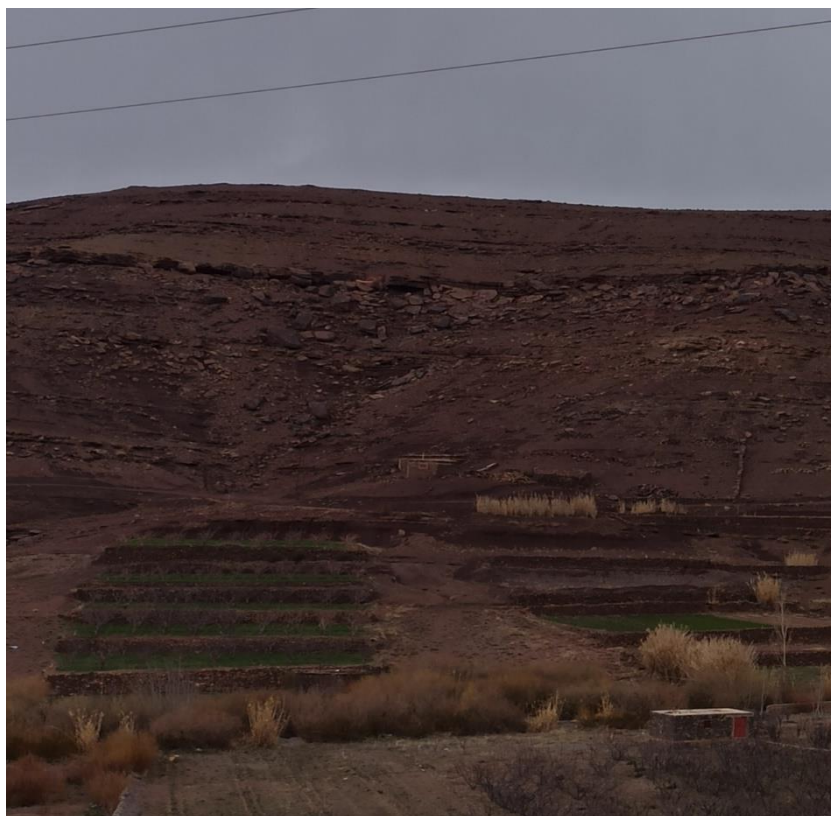
Figure 5 terrasses construites dans la zone
