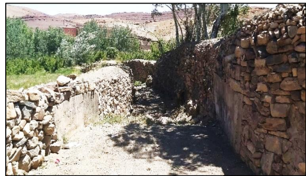
Figure 38 : Gabion pour la voie Khouya Yechou
