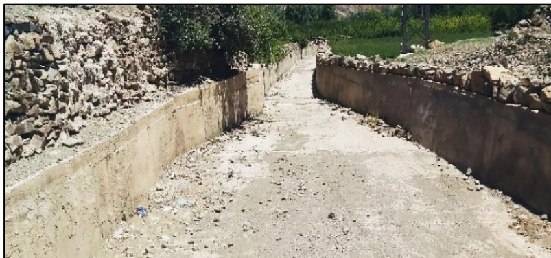
Figure 37 : Gabion en béton pour la voie Talat Noumda
