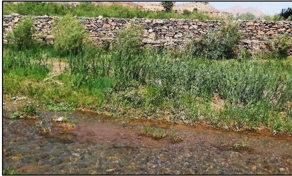
Figure 41 : Gabion pour l'Oued Oussikis à Taadadate
