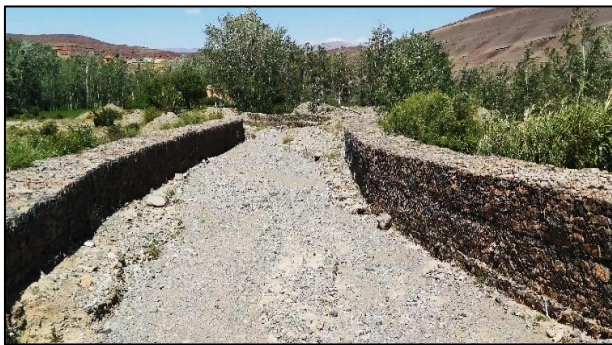
Figure 39 : Gabion pour la voie d'Anmiter
