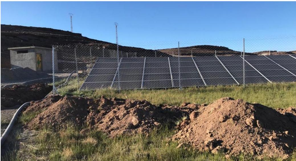
Photo 7 : Station de pompage solaire des eaux souterraines pour l'irrigation à Almou
