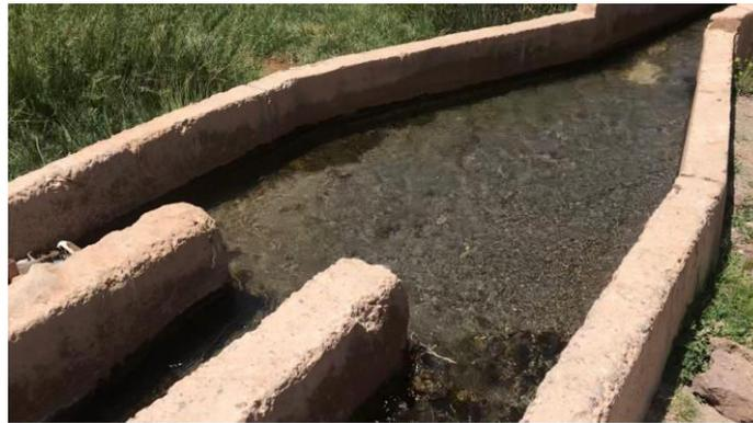
Photo 4 : Répartition des débits suivant le ratio  $1/3-1/3$  à Tilmi en amont de M'Semrir
