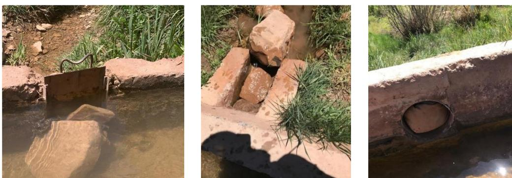
Photo 15 : Prises d'irrigation dans la zone de M'Semrir
