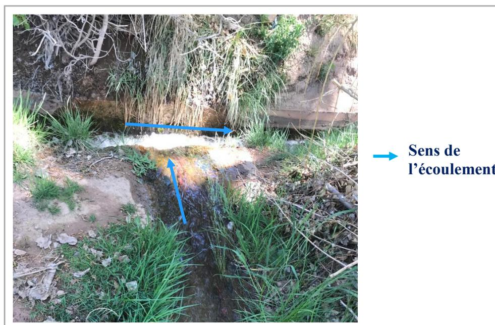
Photo 14 : Point de rencontre entre une séguia de renforcement en terre et une séguia principale en béton dans la zone de M'Semrir
