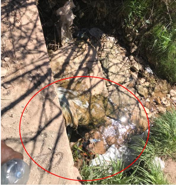
Photo 23 : Fuite d'eau due à une fissure dans le corps de la séguia
