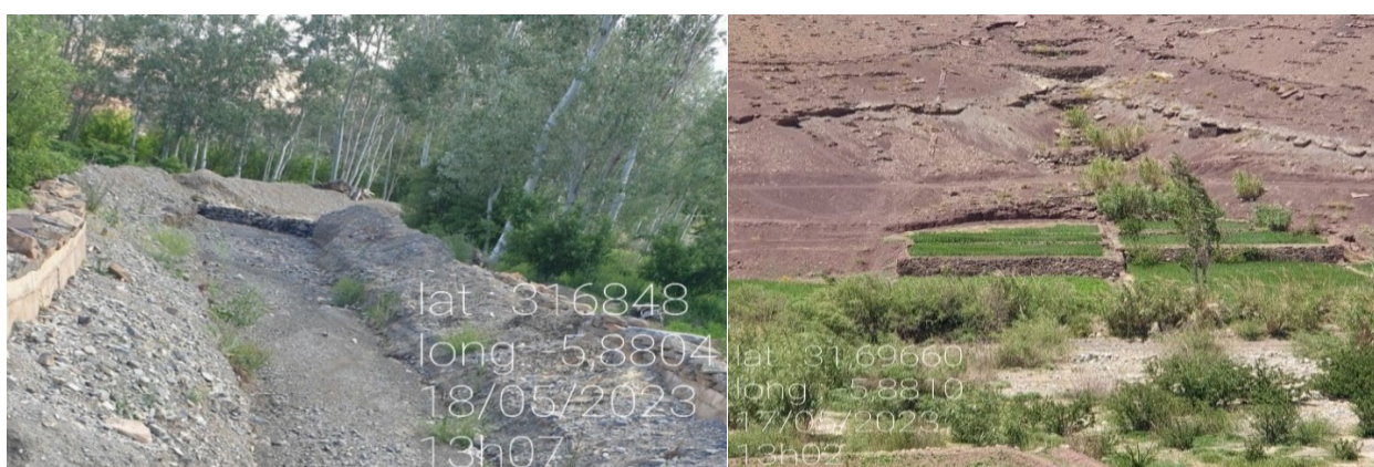
Photo 19 : Seuils en pierres installés sur la zone de M'Semrir
