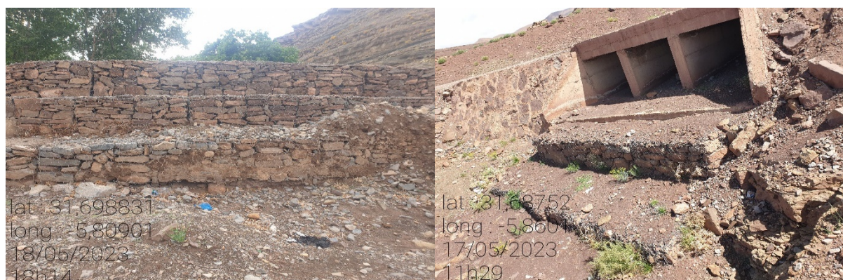
Photo 20 : Seuils en gabions installé sur la zone
