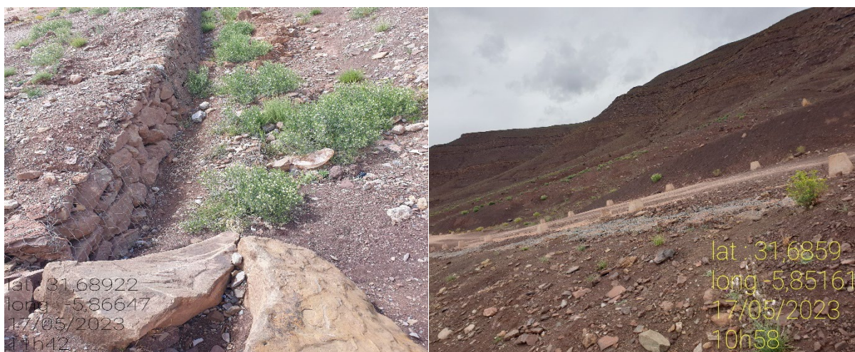
Photo 15 : Seuils en gabions de la zone de M'Semrir
