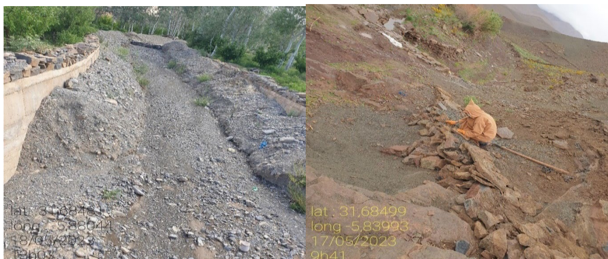
Photo 14 : Seuils en pierres sèches de la zone de M'Semrir
