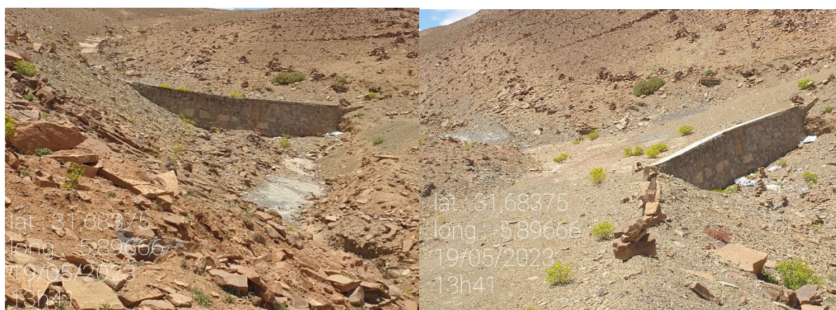
Photo 16 : Seuils en maçonneries dans la zone de M'Semrir
