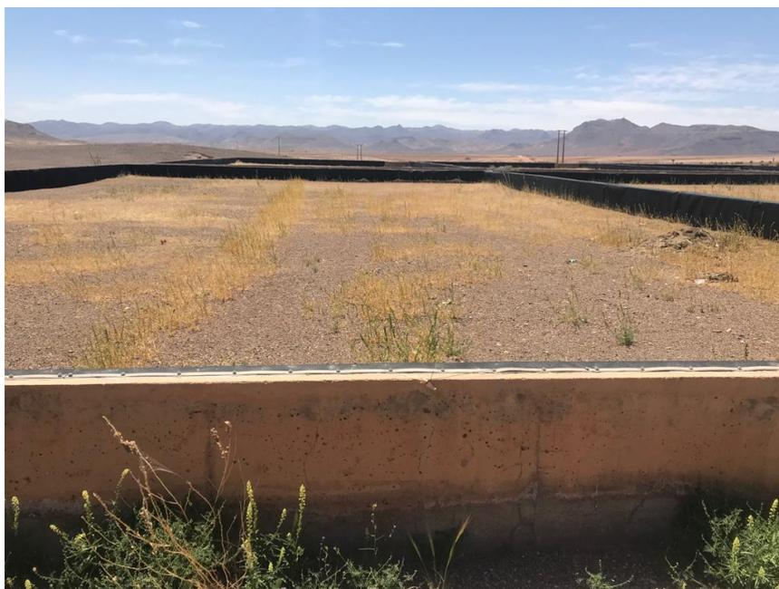
Figure 22 : Lits de séchage de la STEP
