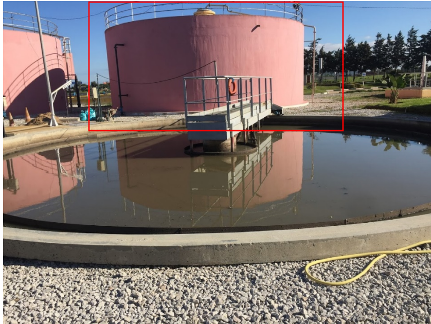
Figure 25: Digesteur anaérobique dans la STEP de Skhirat
