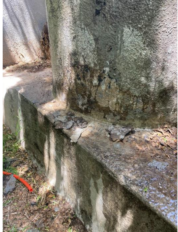
Figure 31 : Fissurations du béton au niveau de la partie non enterrée du RAC
