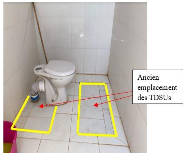
Figure 56 : Remplacement des TDSUs par une toilette à siphon manuel
