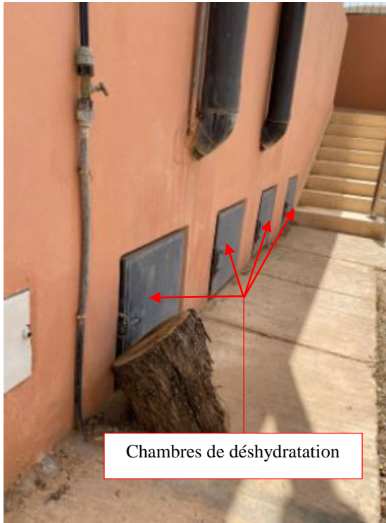
Figure 63 : Chambres de déshydratation des TDSUs existantes au niveau de l'école primaire, munies des tubes de ventilation
