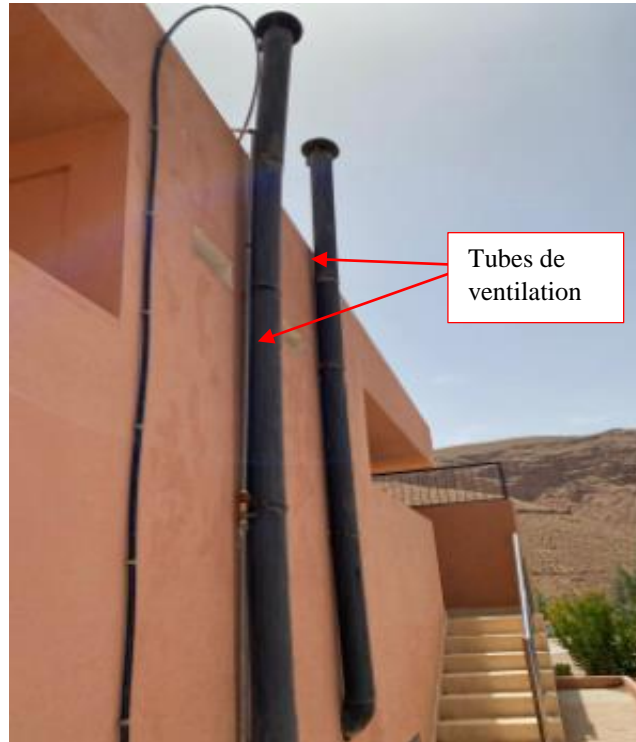
Figure 63 : Chambres de déshydratation des TDSUs existantes au niveau de l'école primaire, munies des tubes de ventilation
