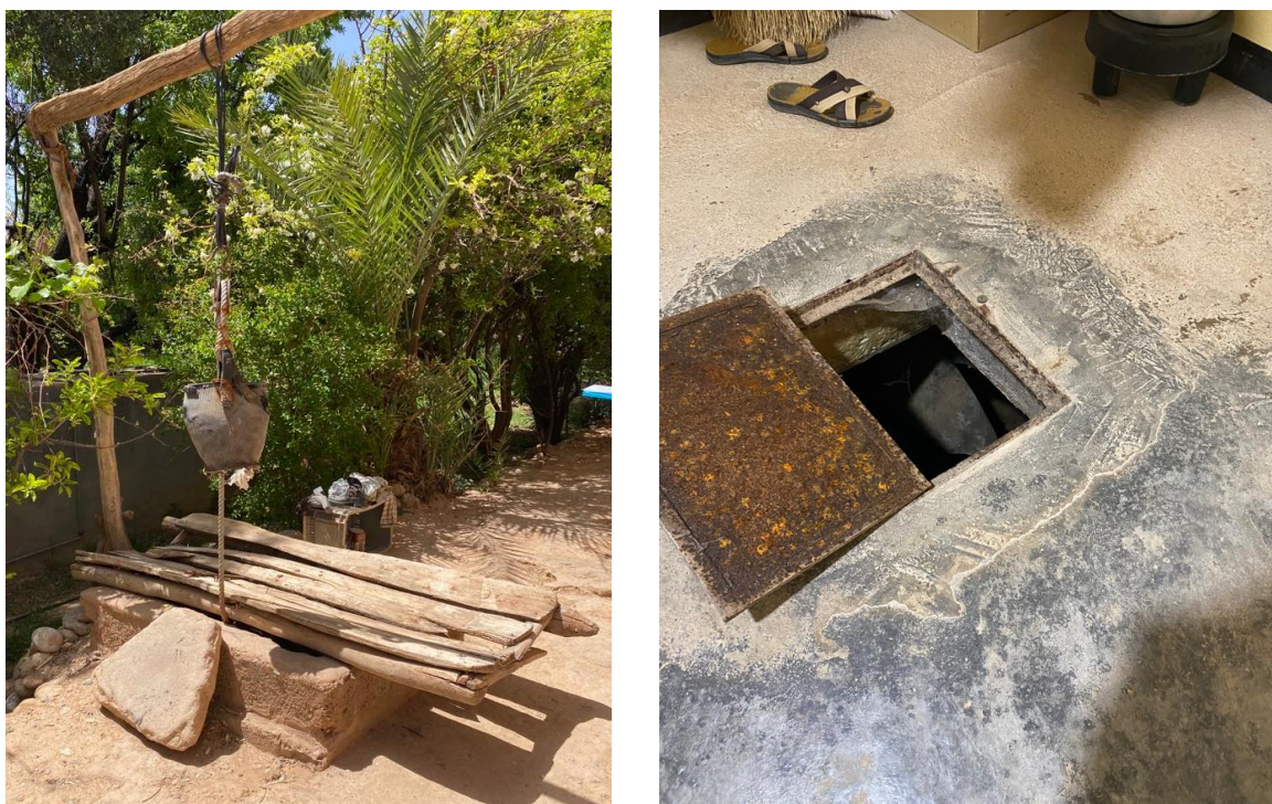
Figure 74 : Puits individuel au niveau de deux ménages de la commune ASJS
