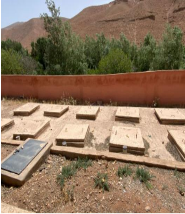
Figure 61: Dix regards des réservoirs enterrés de stockage des urines issues des TDSUs au niveau de l'école primaire
