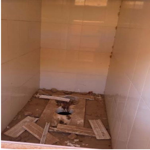
Figure 66: Etat actuel désastreux des cuvettes à séparation d'urines existantes au niveau du marché du village Ait Idir
