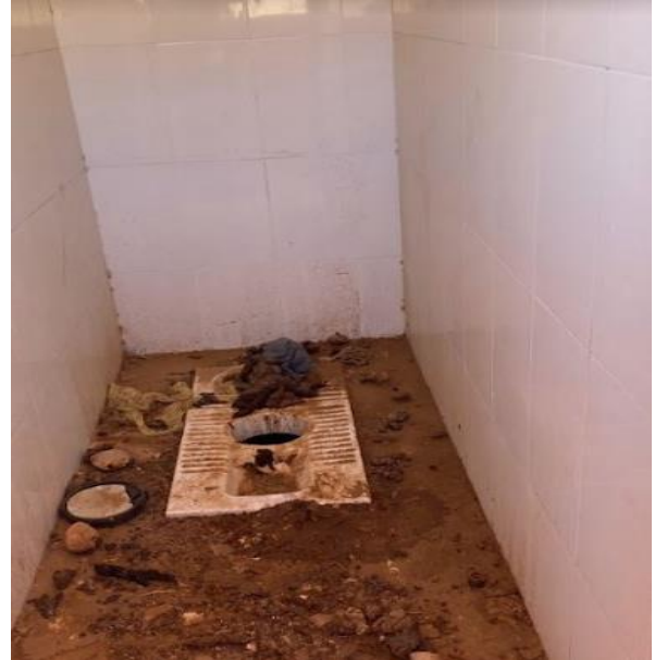
Figure 66: Etat actuel désastreux des cuvettes à séparation d'urines existantes au niveau du marché du village Ait Idir
