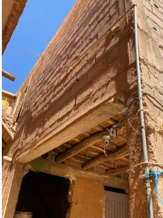
Figure 52: Tuyau galvanisé permettant la conduite de biogaz produit par le digesteur vers la cuisine
