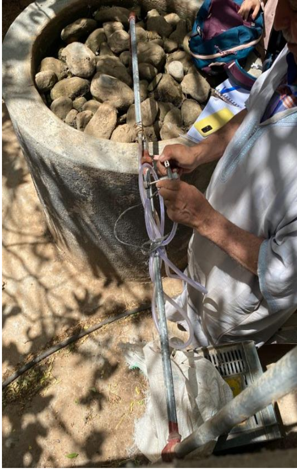
Figure 40 : Pas de production de biogaz par le digesteur
