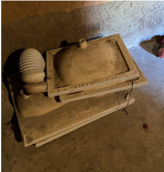
Figure 55 : Cuvettes des TDSUs après remplacement par une toilette à siphon manuel
