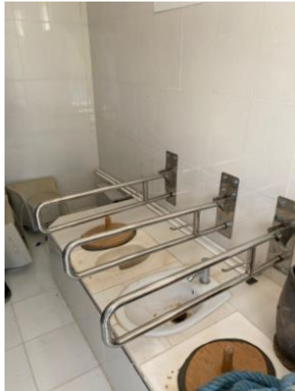
Figure 60: TDSU à position assise au niveau de l'école primaire au village Ait Idir
