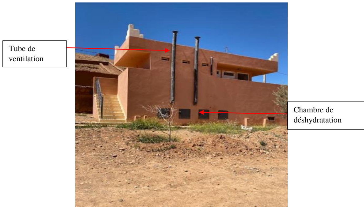
Figure 65: Vue d'extérieur des TDSUs existantes au niveau du marché du village Ait Idir
