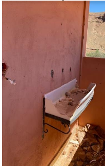
Figure 66: Etat actuel désastreux des cuvettes à séparation d'urines existantes au niveau du marché du village Ait Idir
