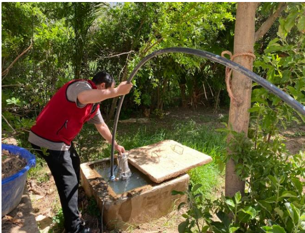
Figure 53: Utilisation d'une pompe électrique pour pomper les eaux usées traitées issues du digesteur anaérobie
