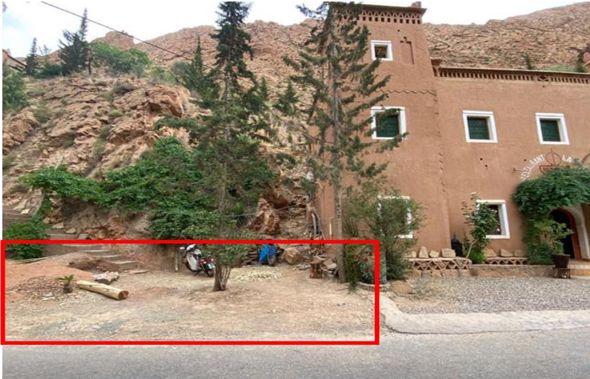
Figure 115 : Espace disponible pour la mise en place du pilote au niveau de l'unité touristique n°6
