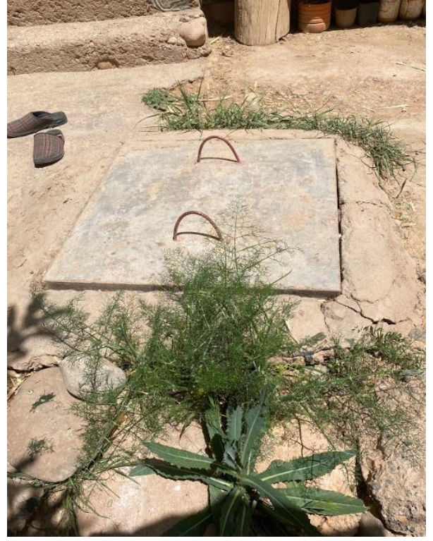
Figure 28 : Regard de la cuve de collecte des eaux usées du ménage
