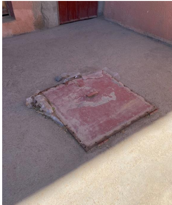
Figure 42 : Mise en place du plastique sous le couvercle de la cuve des eaux usées traitées par le digesteur
