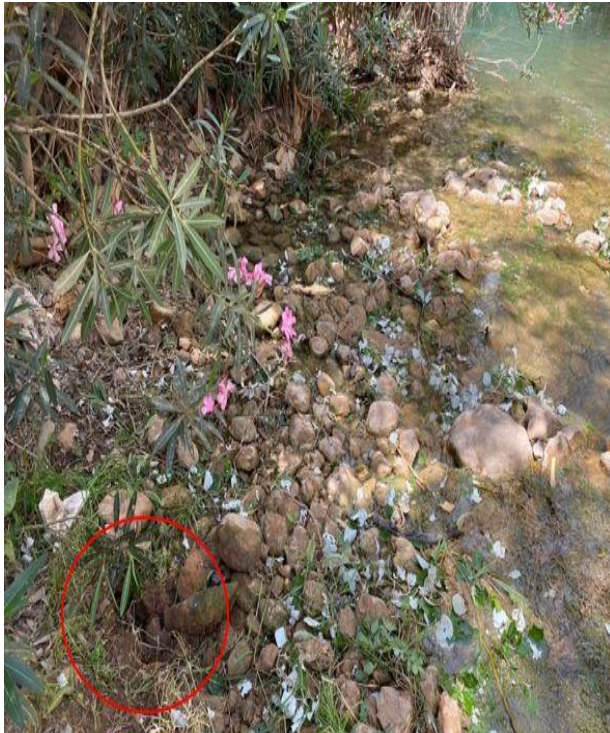
Figure 108 : Emplacement du canal d’évacuation des eaux usées d’une unité touristique directement dans Oued Dadès - Village Ait Oufi- Commune ASJS
