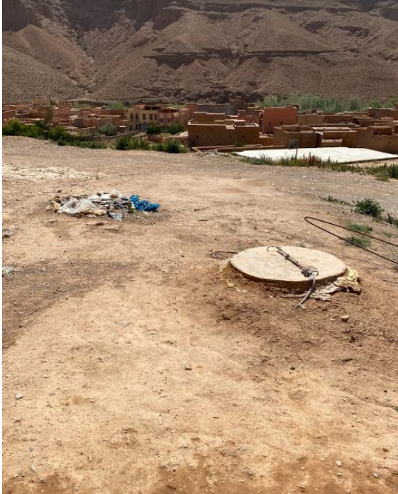
Figure 46 : Regard du bassin d'expansion et regard de la cuve de stockage de digestats
