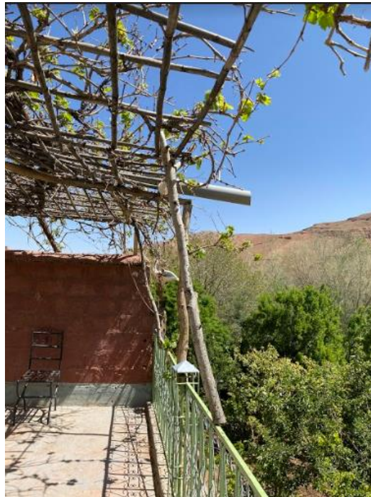
Figure 110 : Conduite d'évacuation des eaux pluviales sur toiture d'une unité touristique – Village Ait Idir – Commune ASJS
