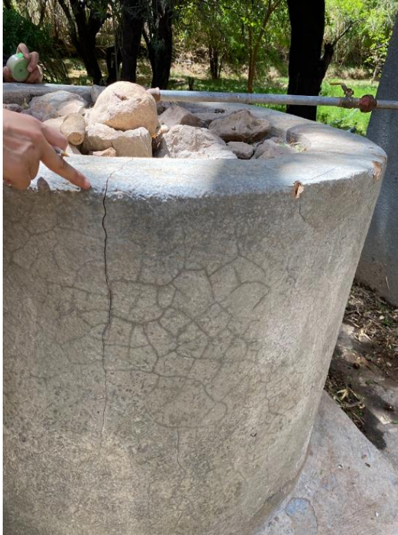
Figure 31 : Fissurations du béton au niveau de la partie non enterrée du RAC
