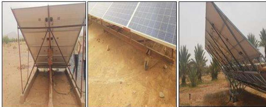
Figure 33 : Installation fixe, installation mobile sur roues et installation mobile à axe rotatif
