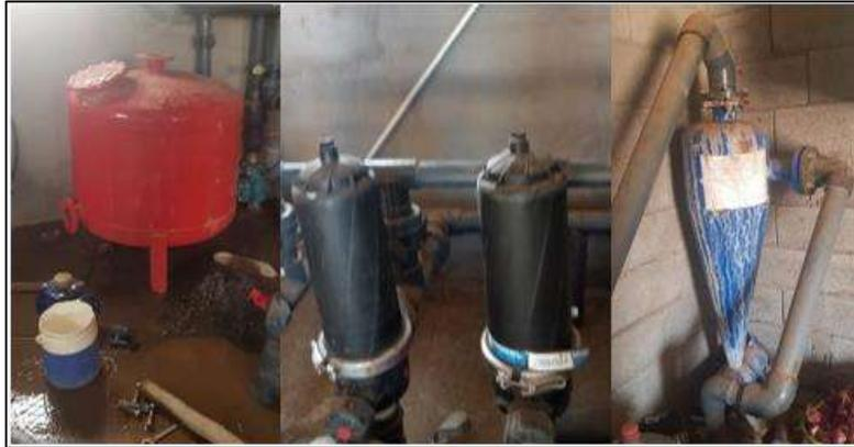
Figure 42 : Filtre à sable, Filtres à disques et filtre hydrocyclone
