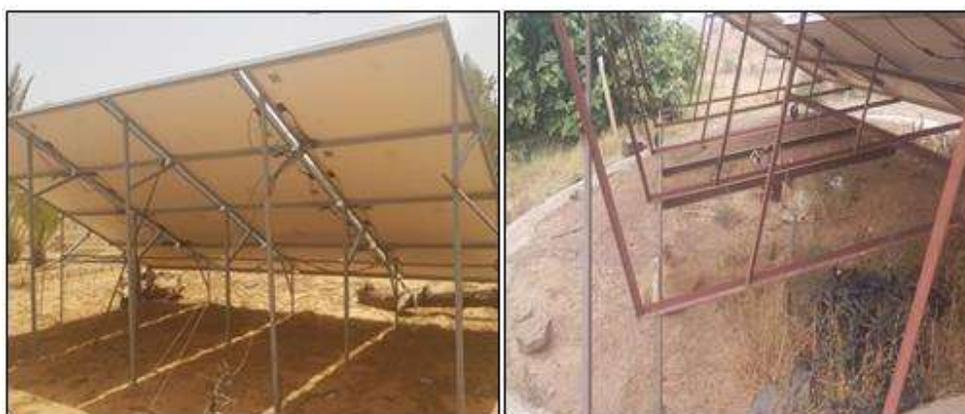
Figure 35 : Châssis en acier protégé et non protégé
