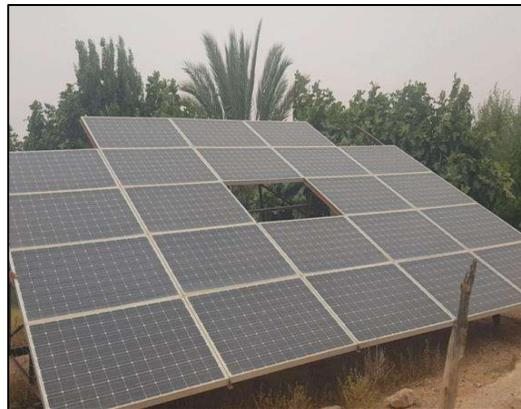
Figure 31 : Exemple d'installation PV avec problèmes d'ombrage
