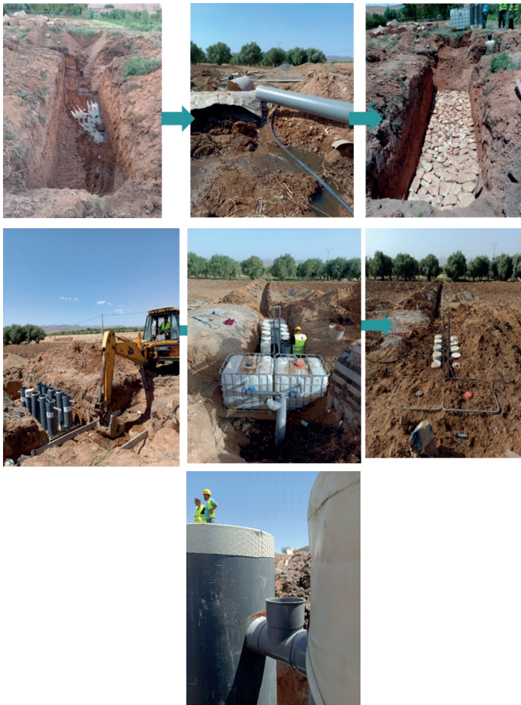
Figure 13: Mise en place du RAC à Biopalace (juin 2023)
