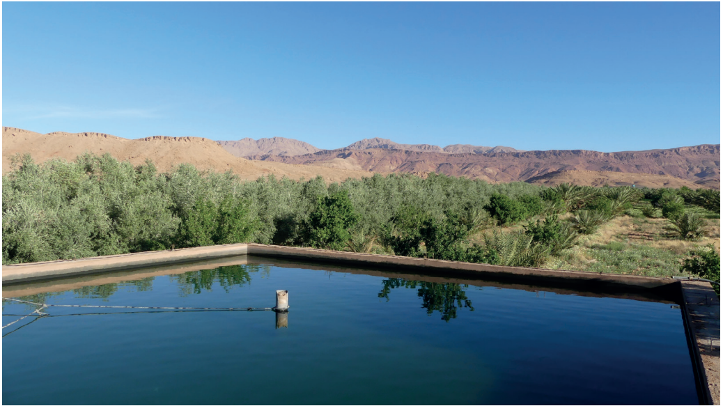
Figure 25 – Réservoir surélevé, pour irriguer en gravitaire dans une extension de la vallée de Todgha (avril 2023)
