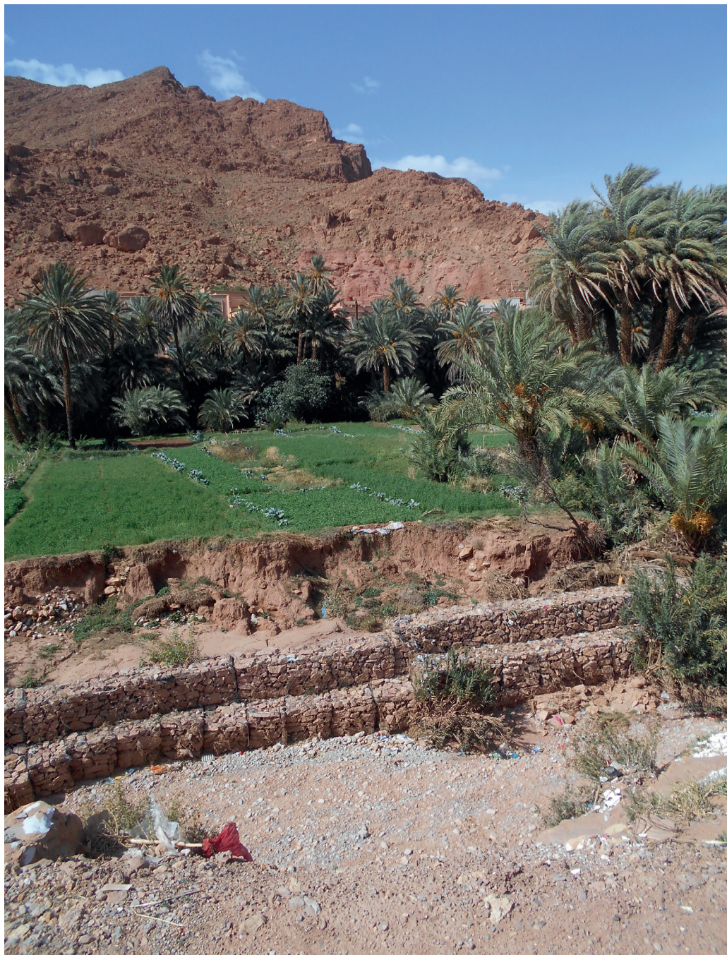
Figure 12 – Consolidation des berges de l'oued Todgha pour lutter contre l'érosion (septembre 2019)
