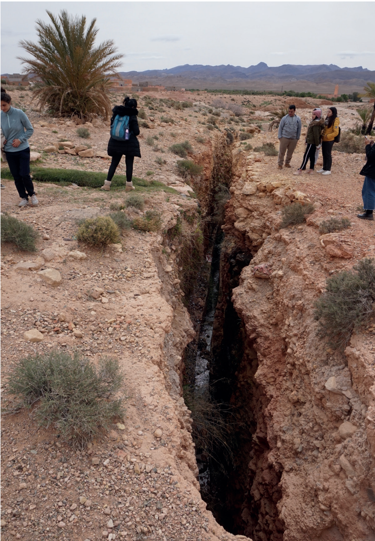
Figure 21 – Galerie drainante souterraine (Khetaras) dans la plaine de Ghellil (février 2022)
