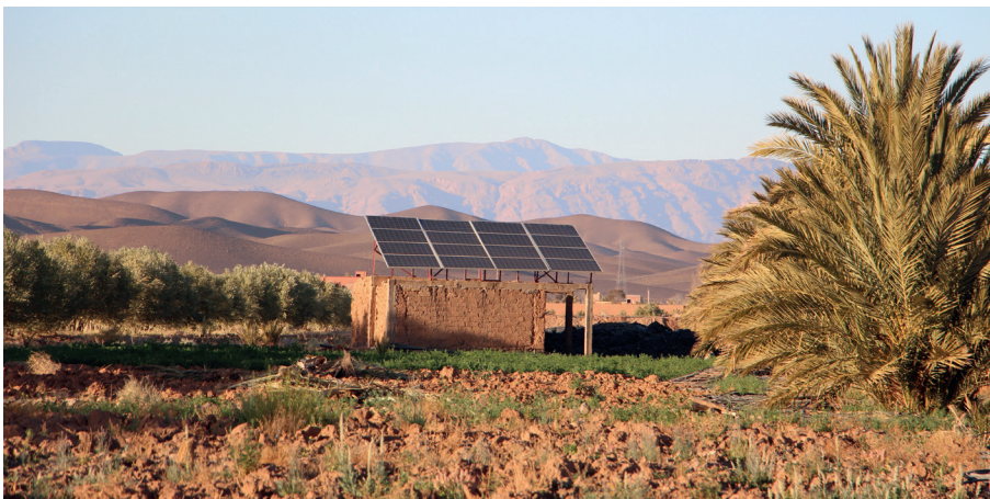
Figure 20 – Parcelles irriguées par un bassin alimenté en eau grâce à du pompage solaire (février 2020)
